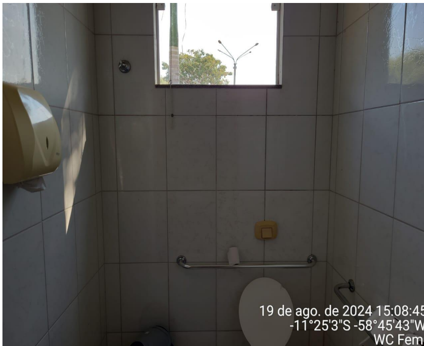
Figura 27 – Sanitário Fem – Instalação de Barras de Apoio Fonte: Pref. Municipal, 2024
