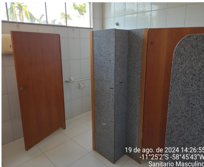
Figura 13 – Instalação da Barra de Apoio em Porta – Sanitário Masc. (Recepção) Fonte: Pref. Municipal, 2024
