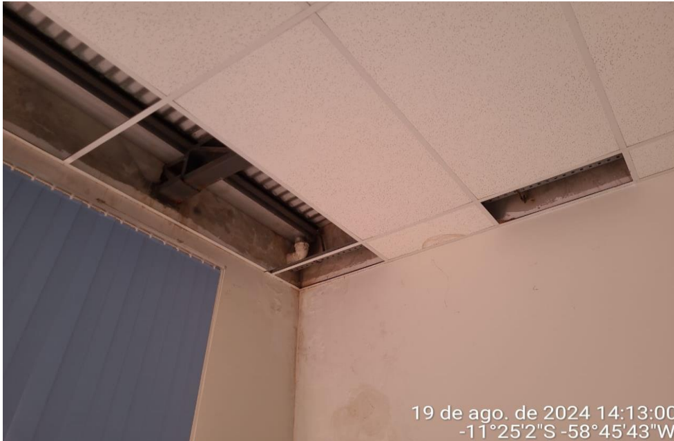
Figura 35 – Plenário – Infiltração da cobertura Fonte: Pref. Municipal, 2024
