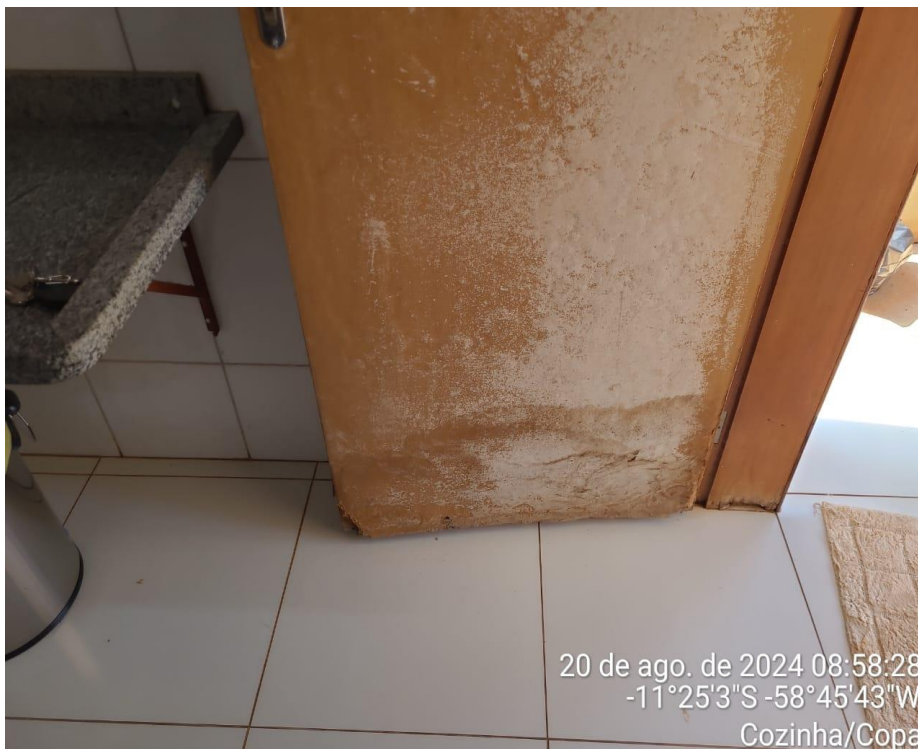
Figura 41 – Porta de Acesso a Varanda da Cozinha / Copa Fonte: Pref. Municipal, 2024
