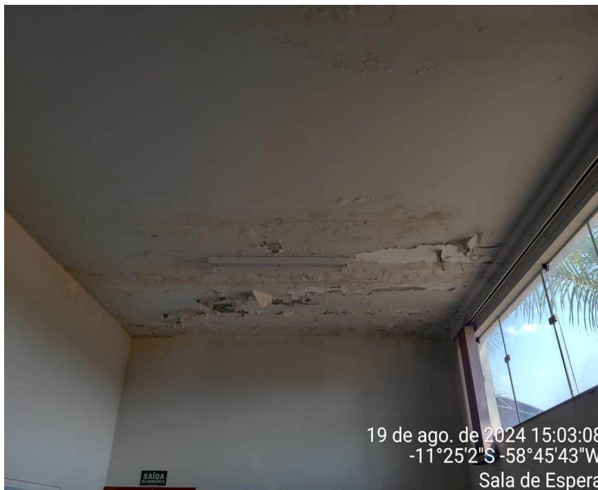
Figura 22 –Sala de Espera – Infiltração em Laje Fonte: Pref. Municipal, 2024
