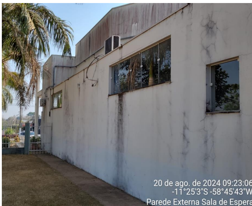
Figura 52 – Parede Externa da Sala de Espera – Local de Construção da Platibanda Fonte: Pref. Municipal, 2024
