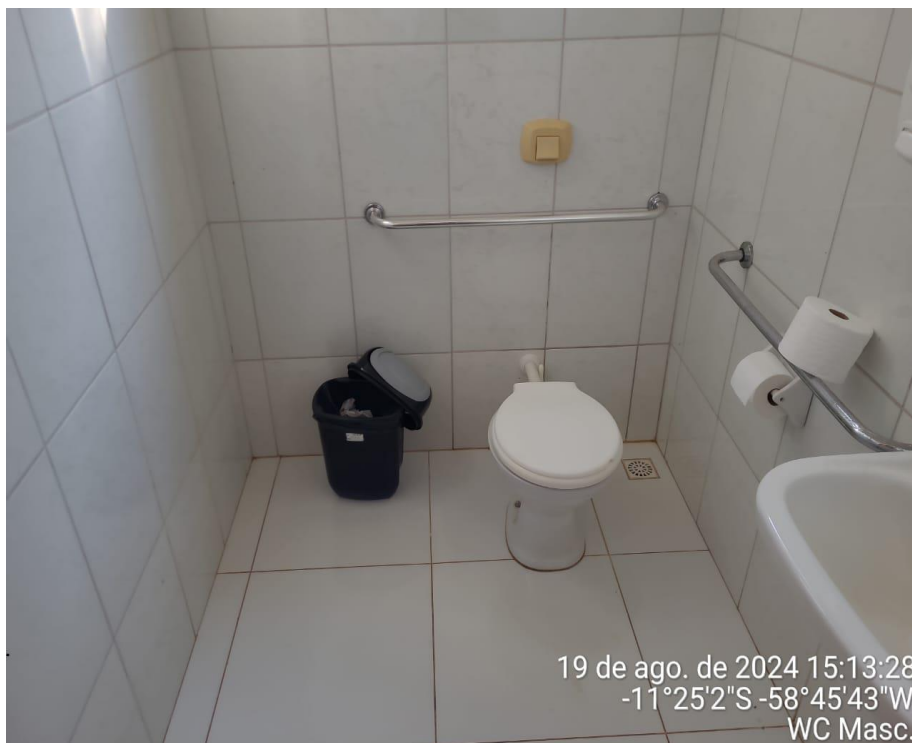
Figura 29 – Sanitário Masc – Instalação de Barra de Apoio
