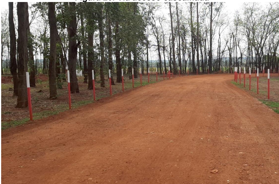
Figura 20. Via acesso cascalhada
