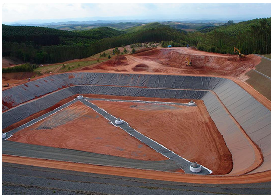
Figura 19. Impermeabilização taludes e célula
