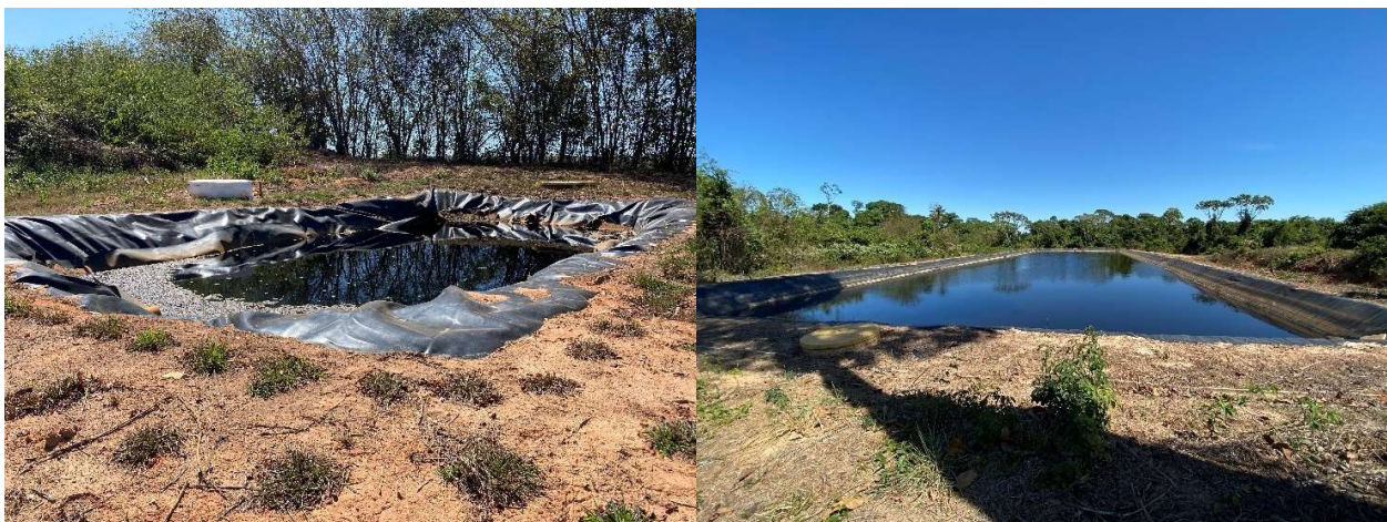
Figura 15 – Lagoa anaeróbia e lagoa facultativa, respectivamente
