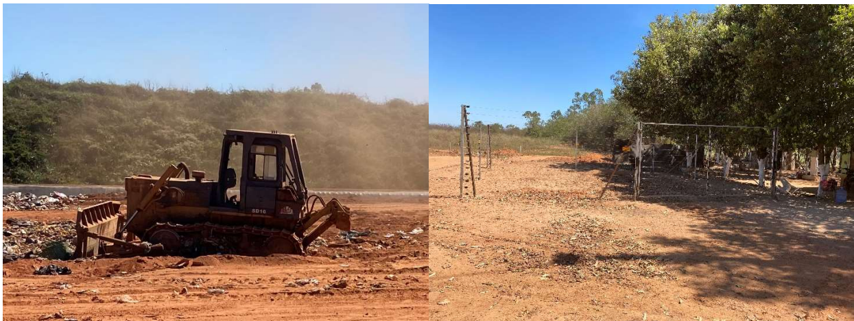
Figura 17 – Trator de esteiras e área cercada para armazenamento, respectivamente
