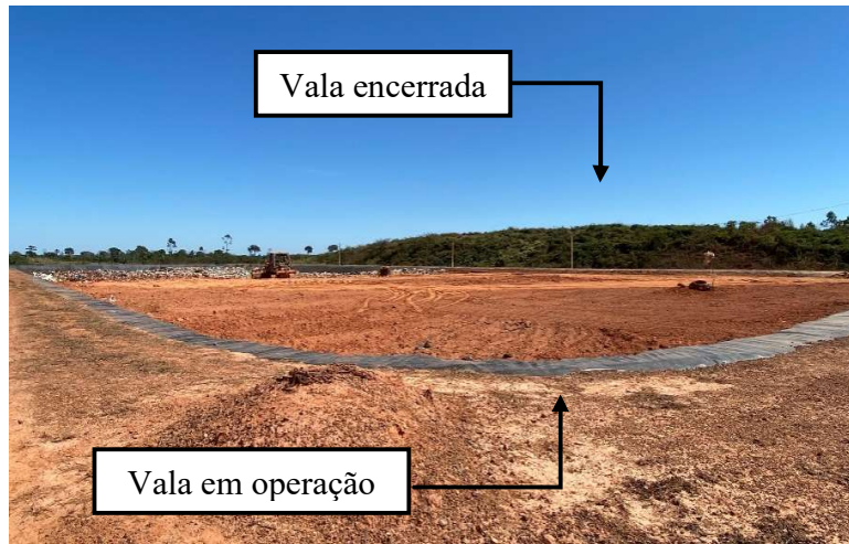
Figura 12 – Vala em operação e vala encerrada ao fundo
